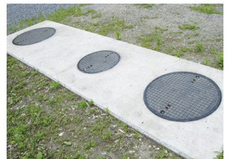
▲浄化槽外観の例
