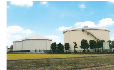
▲北部配水場・地上式配水池
