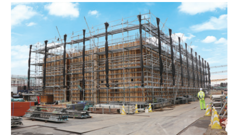
▲北部配水場・配水ポンプ棟工事現場
