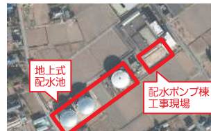
▲北部配水場・上空写真
