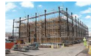
▲北部配水場・配水ポンプ棟工事現場
