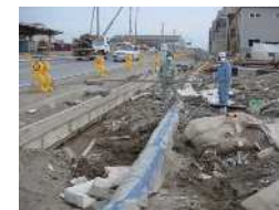
▲耐震継手管の様子（被害なし） （公益財団法人日本水道協会提供）
