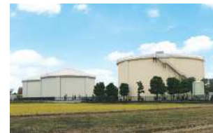
▲北部配水場・地上式配水池
