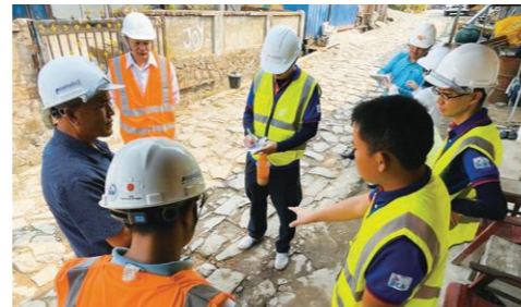
老朽管更新現場における検証（2020年代）
