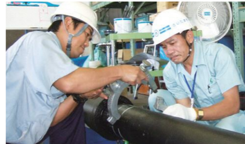
水道管の接合実習（2000年代）
