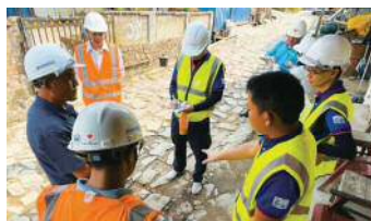
老朽管更新現場における検証（2020年代）
