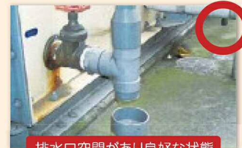
排水口空間があり良好な状態
