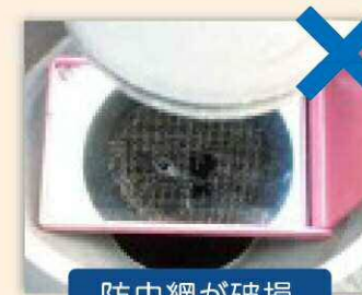
防虫網が破損
