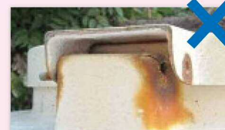
連結棒が欠落し、本体にも亀裂
