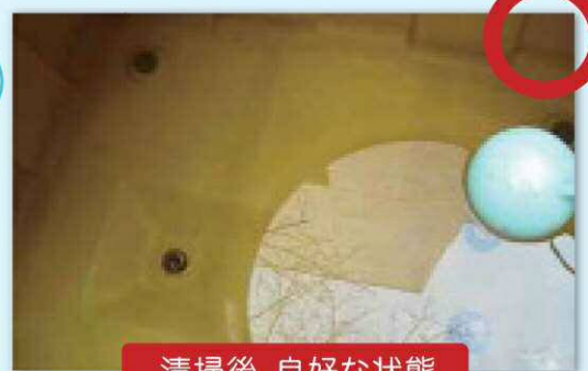
清掃後、良好な状態
