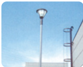
外灯LED化 (浄配水場)
