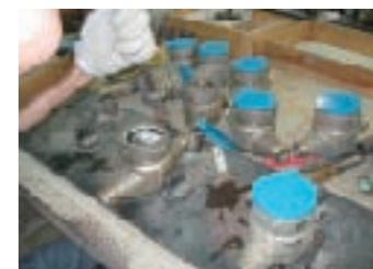
水道メーターの再資源化
