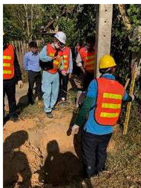
給水管施工現場におけるOJT (ルアンパバーン県水道公社)
