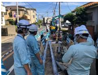
配水管施工現場でのOJT
