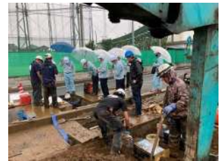
給水管施工現場でのOJT
