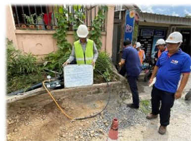
ポンサリー県における工事管理の改善状況(給水管工事)
