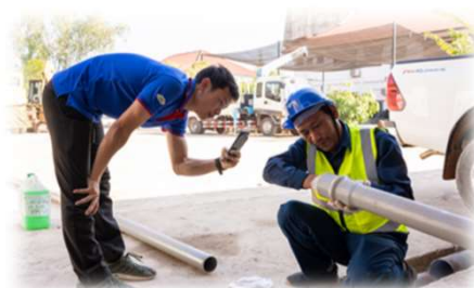
施工教育現場用ビデオ撮影 (塩化ビニル管)
