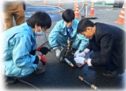
OJT(漏水修繕)
