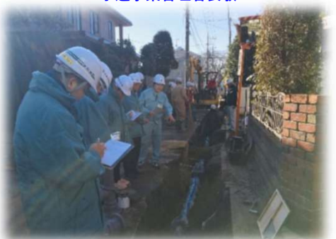
OJT(配水管工事管理)
