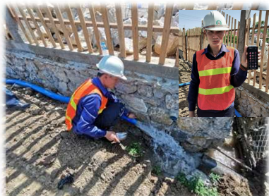
OJT(排水作業&残留塩素測定)
