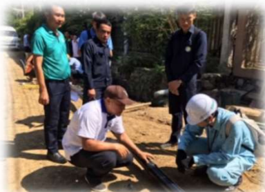
OJT(管継手工)
