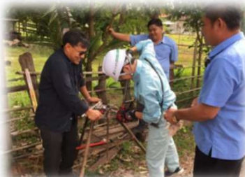
OJT(管継手工 鋼管ネジ切)
