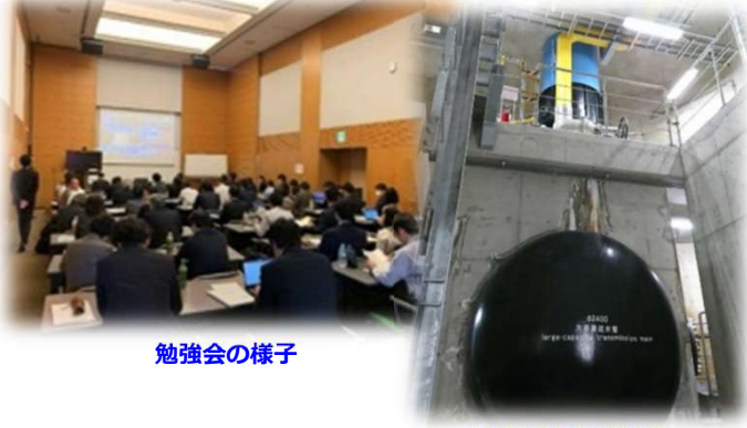
大容量送水管立坑内 (Φ2400mm,地下約50m)
