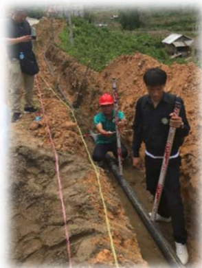
配水管土被り検測状況 @ルアンパバーン県水道公社
