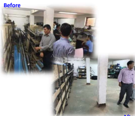
Before 配給水管材料倉庫内改善状況 @カムアン県水道公社 After
