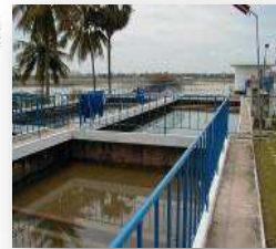
1964年に日本の支援で建設されたラオス初の浄水場(ビエンチャン)
