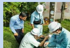
給水管接続現場における 技術指導(耐圧試験)
