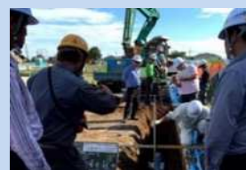
研修員受入 (配水管施工現場視察)
