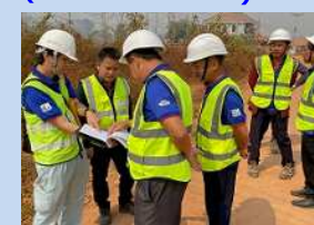
施工現場における技術指導 (施工計画の確認)
